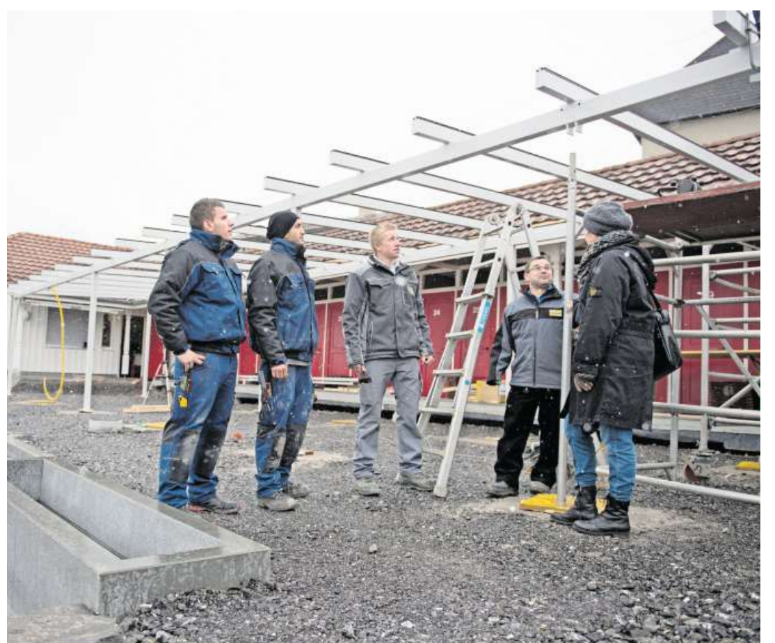
Bauarbeiter besprechen die anstehenden Arbeiten mit Bauleiterin Isabelle Winterhalder (ganz rechts). Bild: Corinne Glanzmann (Sachseln, 17. Januar 2018)
